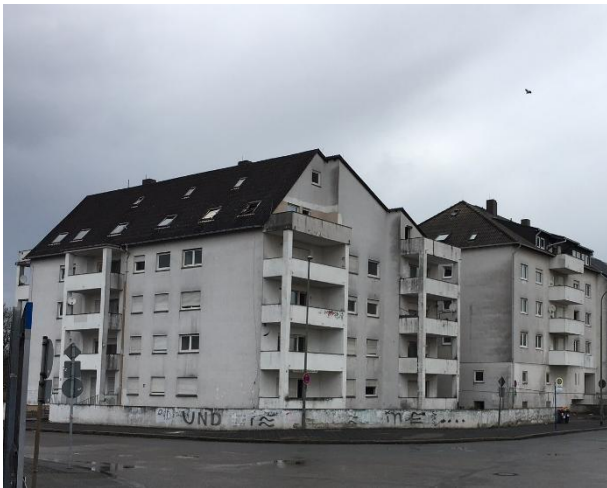
Abb. 57 Wohnbebauung Ecke Boschstraße / Daimlerstraße im Mai 2018
